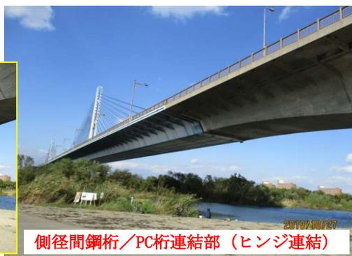
側径間鋼桁/PC桁連結部（ヒンジ連結）
