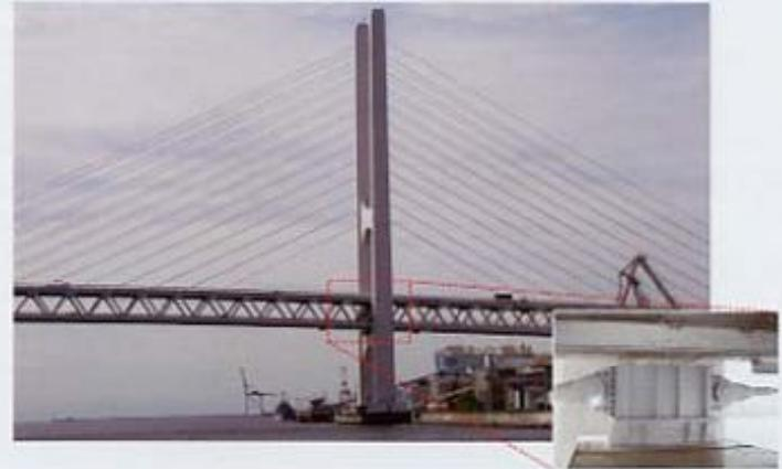
東神戸大橋では、オールフリーの支持形式(塔や橋脚の支承で主桁を支えず、ケーブルで主桁を吊り下げる形式)を採用しており、大地震に対して過大な主桁の変位が生じる恐れがあります。そこで、過大な主桁の変位を抑制するため、縦置きサンドイッチ型積層ゴムダンパーとケーブルを組み合わせた制震装置を設置しました。「縦置きサンドイッチ型積層ゴムダンパー」とは、積層ゴム(ゴムと鋼板を積層状に重ね上げた装置)を縦方向に配置し、サンドイッチ型とすることで積層ゴムが大地震に対してスムーズに変形することを特徴とする制震装置です。
