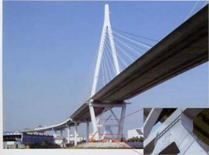
天保山大橋では、塔下部の斜材と水平ばりが交わる接合部(ガセット部)に「せん断パネルダンパー」を設置して地震力を低減しています。せん断パネルダンパーとは、低降伏点鋼(降伏点が一定で想定する荷重で確実に塑性化するじん性に富む鋼材)で構成される鋼板がせん断方向に変形し、塑性化することで地震エネルギーを吸収する制震装置です。塔斜材が座屈(両端から強い圧縮力を受けてひしゃげるように破壊すること)するのを防止し、地震力を低減することで主桁の支承が損傷することも防ぎます。
