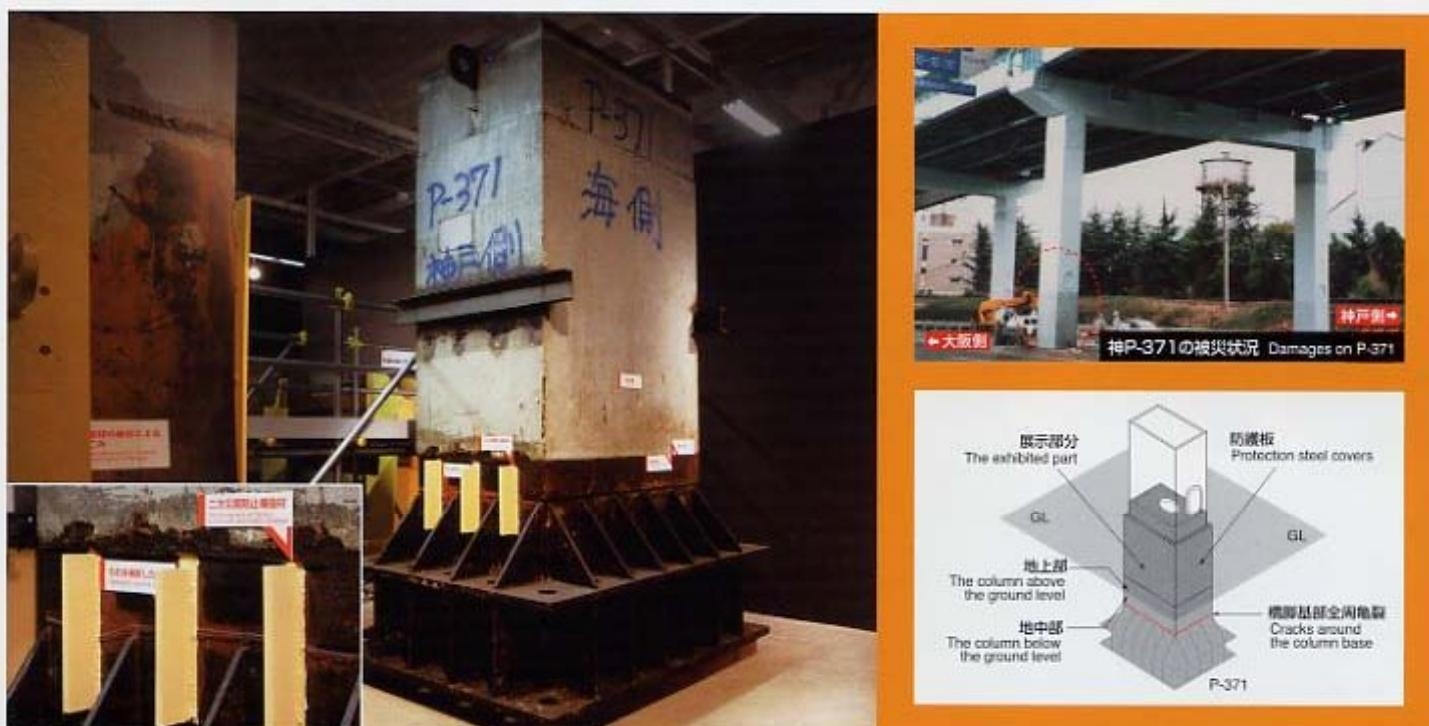
■損傷内容／山側橋脚柱基部(地中部)の補剛材上端において、ほぼ全周にわたる亀裂が生じた
