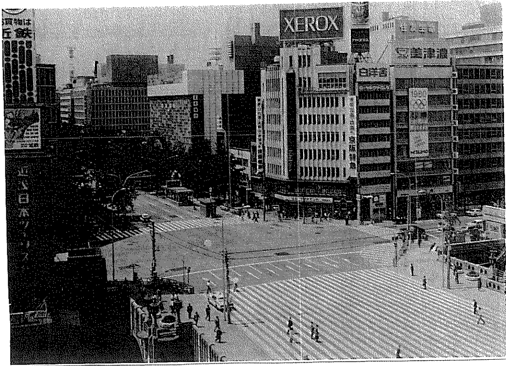
写真-3 昭和53年春 工事着手前 淀屋橋交差点全景
