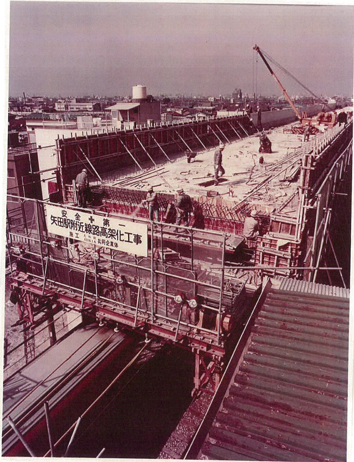
写真-1 移動式型枠支保工(トラベラー)
