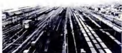
写真-1 上空から見たありし日の吹田操車場 (1970 年頃の写真)
