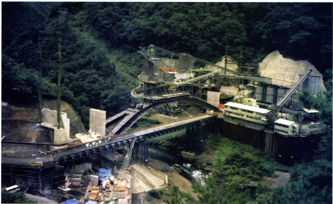
写真-7 工事の様子—ロープウェイの下駅(中央上)、架設中の鋼アーチ橋(中央)、工事用の橋右側に骨材ビン、ざりビンが見える(手前)。これらはすべてロープウェイで運び込まれた。(提供:刈谷健彦氏)
