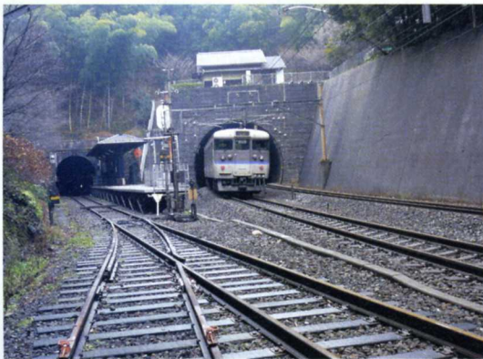
写真-4 明治のトンネル(左)と平成のトンネル(右)
