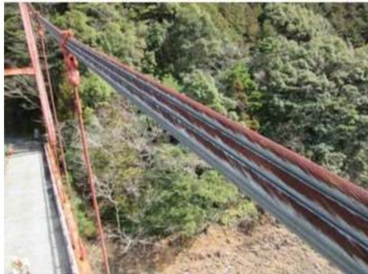
アンカレイジ定着部近傍の腐食
