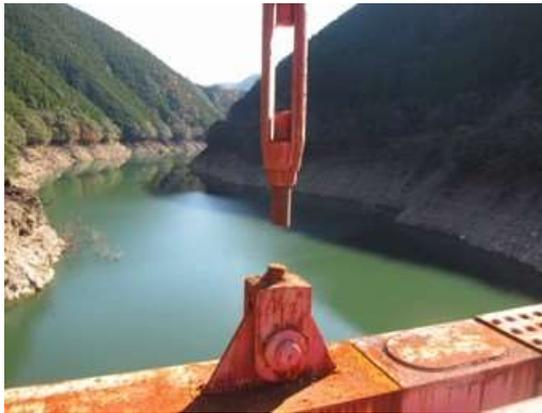
ロッドの破断面
