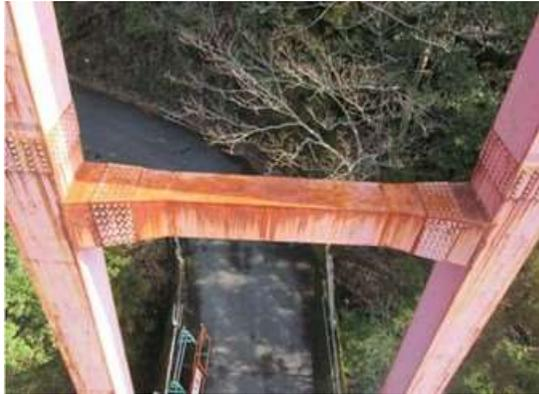
塔頂サドルのボルト脱落
