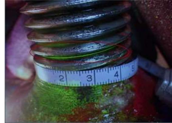
ロッド定着部の表面の縦割れ    ロッドおよび定着部の表面錆    ゆるみ止めナットのゆるみ
