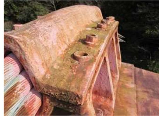
支承部の断面欠損を伴う腐食
