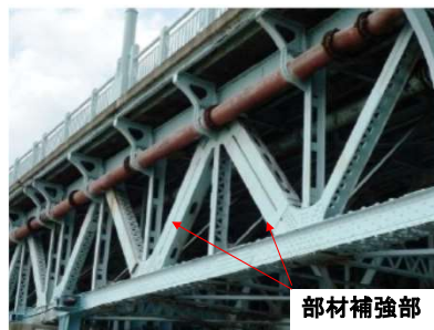
斜材のバイパス補強
