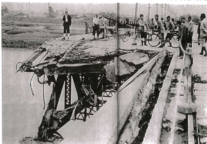
空襲で破壊された淀川大橋
