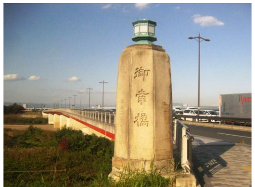
写真14-1 旧御幸橋親柱(京都府八幡市,木津川)
