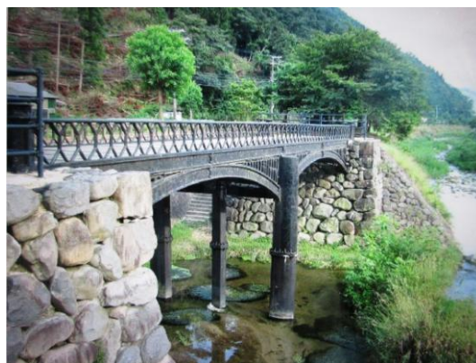
写真2 羽淵鉄橋(兵庫県朝来市,円山川)
