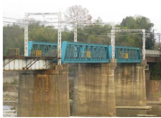
写真8 加古川橋梁(兵庫県小野市,加古川)
