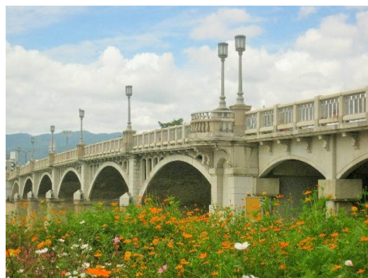
写真4 武庫大橋(兵庫県西宮市,武庫川)
