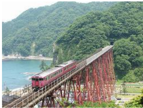
写真 16-1 旧余部鉄橋(全景、兵庫県香美町)
