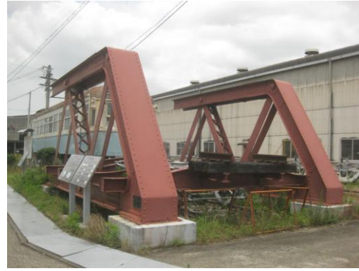
写真 15 旧舞子跨線橋(山陽電鉄車両工場内)
