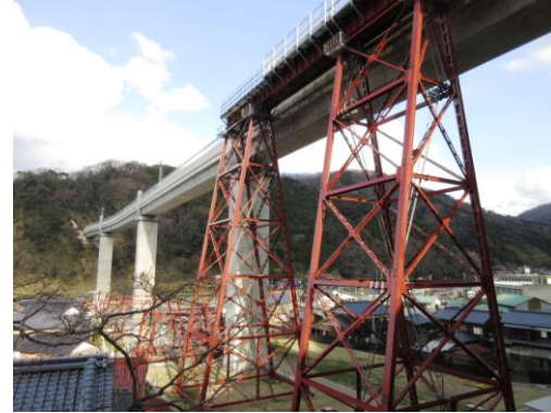
写真 16-2 旧余部鉄橋(展望テラス,兵庫県香美町)
