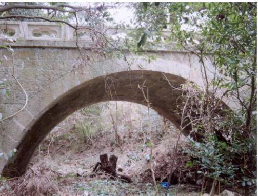
写真11 八幡橋(兵庫県南あわじ市, 賀集八幡神社境内脇)
