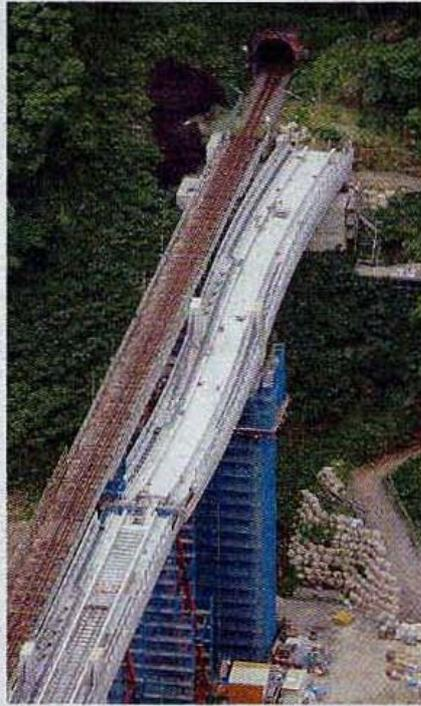
げたは緩いS字形とし、橋脚と斜面の橋台に載せた状態になっている。
