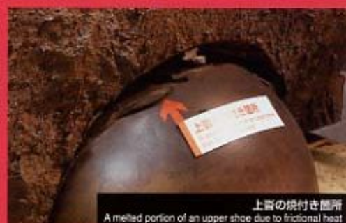
海 P-100 ピボット支承の損傷状況 Damages on P-100
