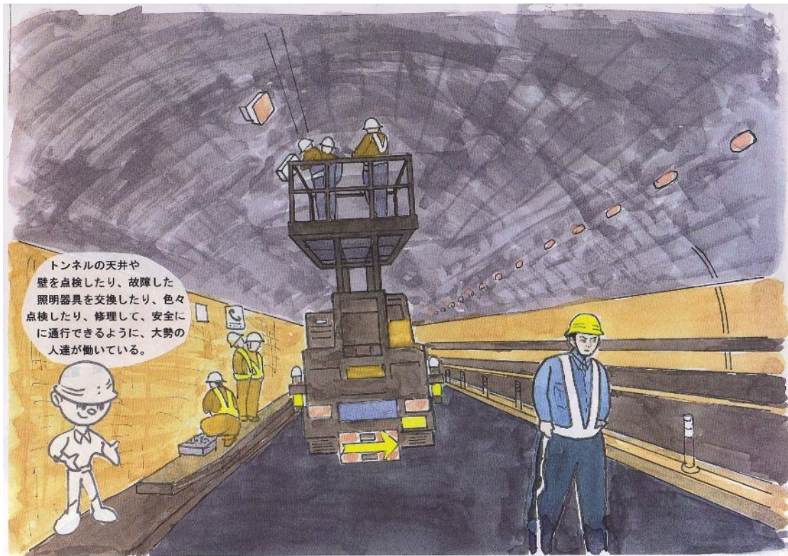
トンネル（照明器具等）の点検
