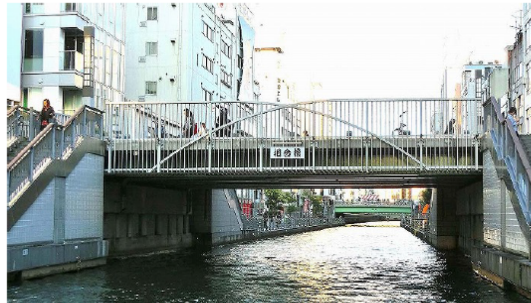
全景 (下流側) (船上から)
