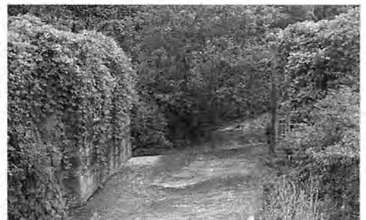
今も残る旧線の橋台
